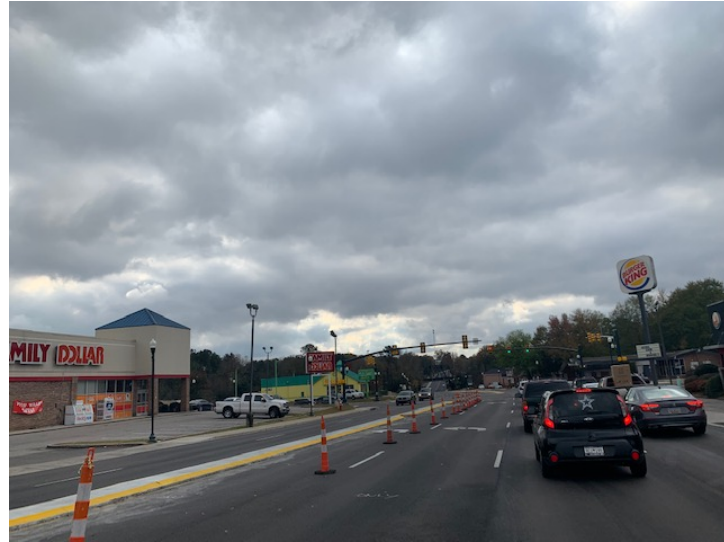
N. Main St. Widening
