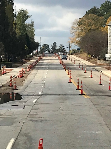
N. Main St. Widening
