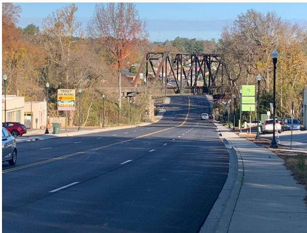
N. Main St. Widening
